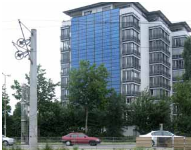
Façade solaire sur un immeuble rénové, Fribourg (Allemagne) © MDH
